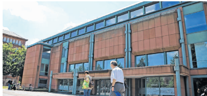
Seine Tage sind gezählt: Bald wird der Bauzaun vor dem Mitzlaff-Bau der Kunsthalle aufgestellt.
